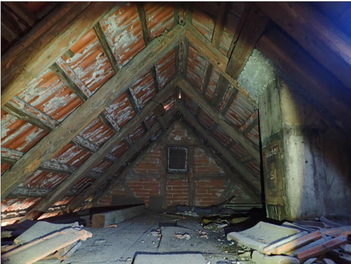
Abbildung 12: Dachstuhl des Wohnhauses in der Haller Straße 31 mit potenziellen Hangplätzen für Fledermäuse an Holzbalken und Streben.
